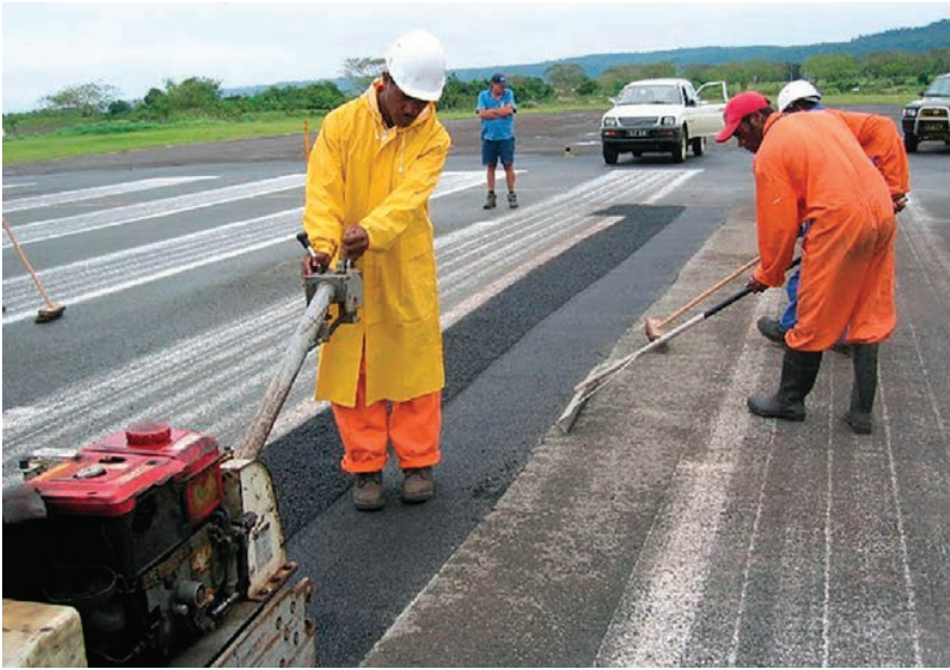
A la izquierda, los operarios aplican la mezcla en frío en la pista de un aeropuerto en el Pacífico Sur. Arriba, el asfalto de mezcla en frío es utilizado para construir una carretera en una mina en Chile.
