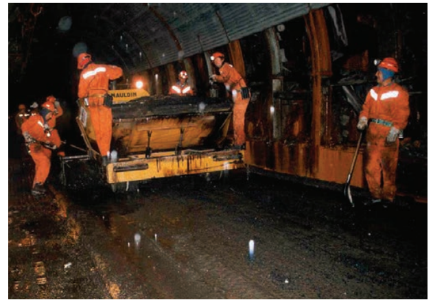
A la izquierda, los operarios aplican la mezcla en frío en la pista de un aeropuerto en el Pacífico Sur. Arriba, el asfalto de mezcla en frío es utilizado para construir una carretera en una mina en Chile.
